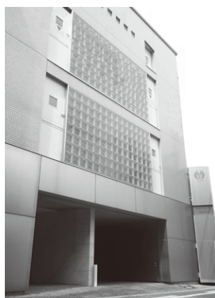
同窓会館(大阪体育大学アネックス)
